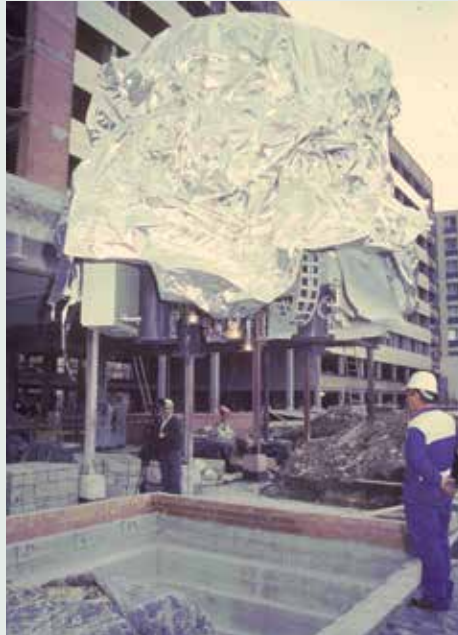
Los técnicos hacen descender el acelerador de partículas muy delicadamente hacia el búnquer.
