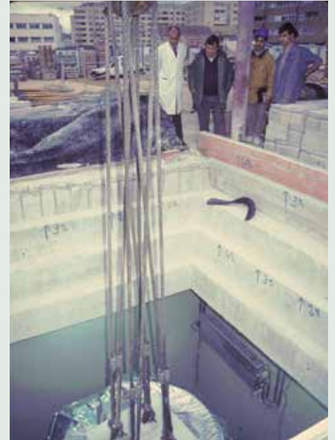
El Dr. Richter acompañado de los técnicos contempla el descenso del ciclotrón y su implantación en el interior del búnquer.
