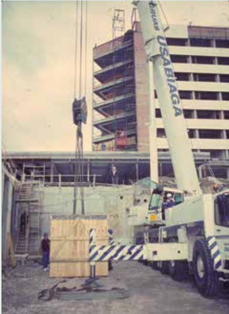
Llegada del Ciclotrón en 1996. Las dimensiones y peso del equipo hacen necesaria su descarga con grúa.
