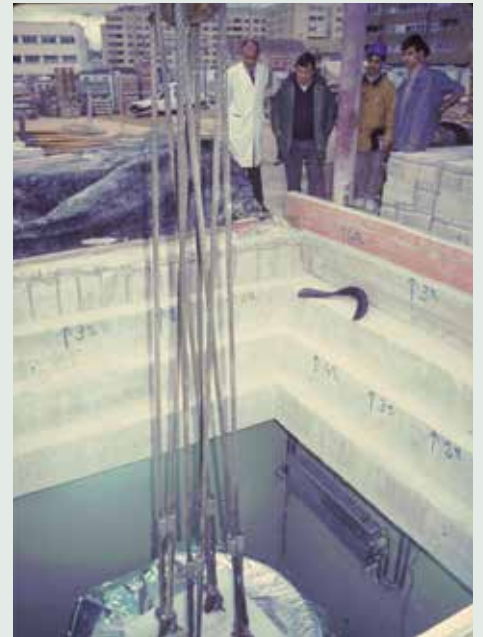
El Dr. Richter acompañado de los técnicos contempla el descenso del ciclotrón y su implantación en el interior del búnquer.
